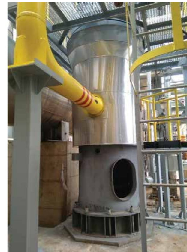
Фильтр-сепаратор масла
